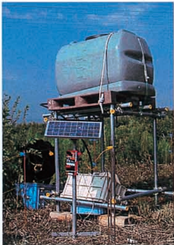
写真1 電気柵・飲水施設
